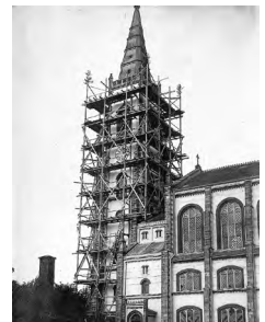
Turm, eingerüstet mit Holzgerüst, vermutlich 1929
