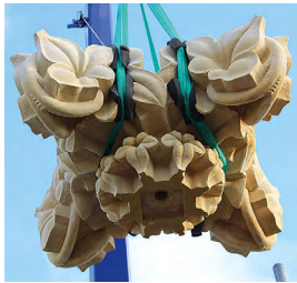
Die neue Kreuzblume wird aufgesetzt
